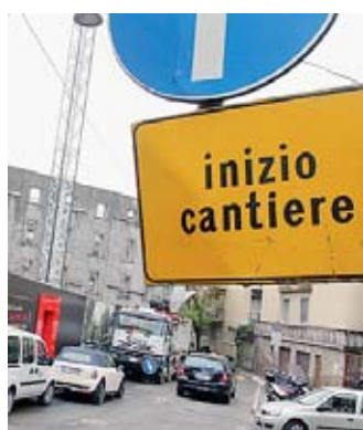
L'area del cantiere FOTO COLLEONI
