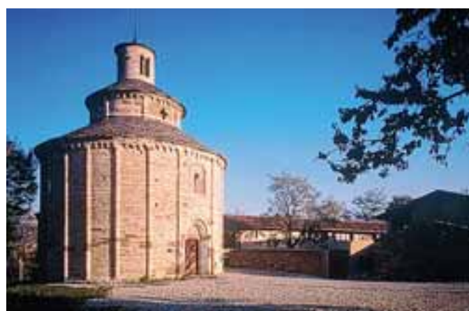
San Tomè ad Almenno San Bartolomeo, sede del Centro studi sul romanico
