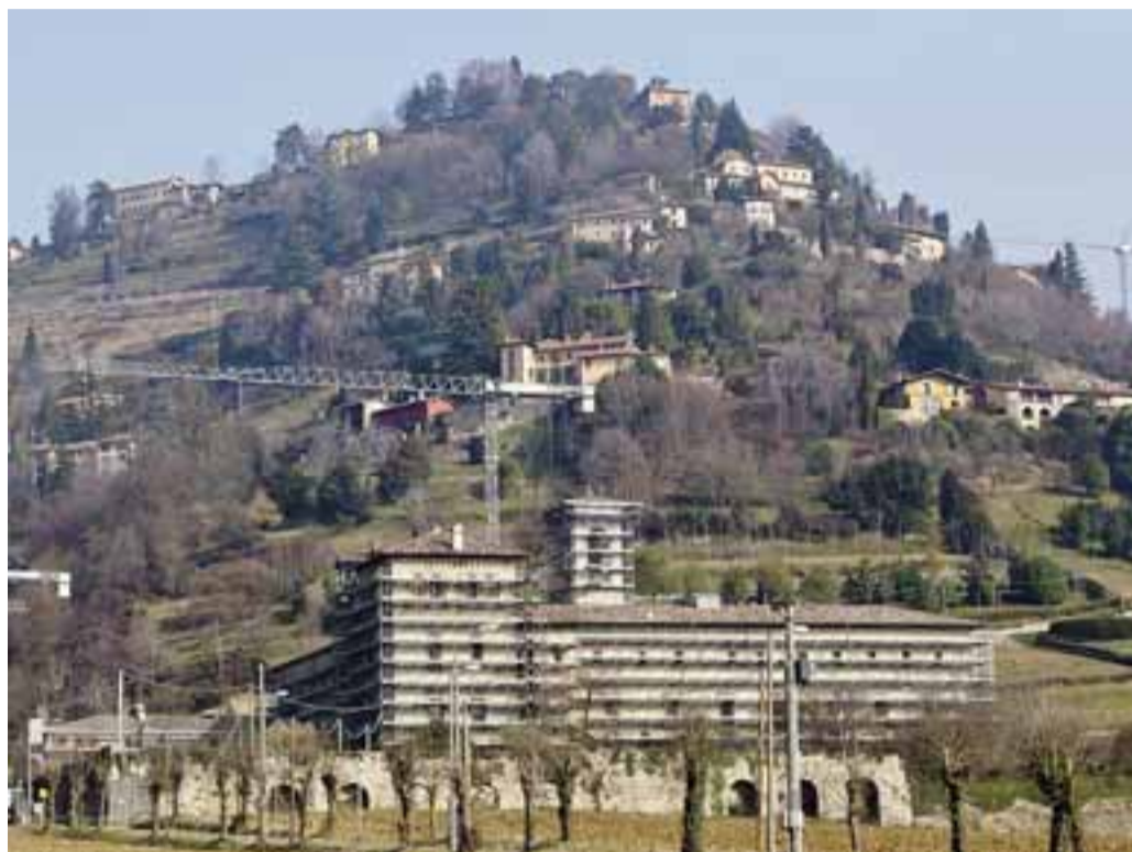
Il cantiere della General Casa per il recupero del monastero di Astino
