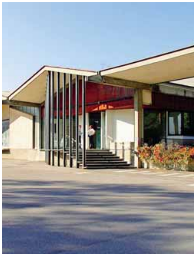
La sede del gruppo Pozzoni a Cisano Bergamasco
